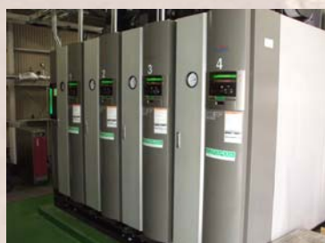
天然ガスボイラ更新
